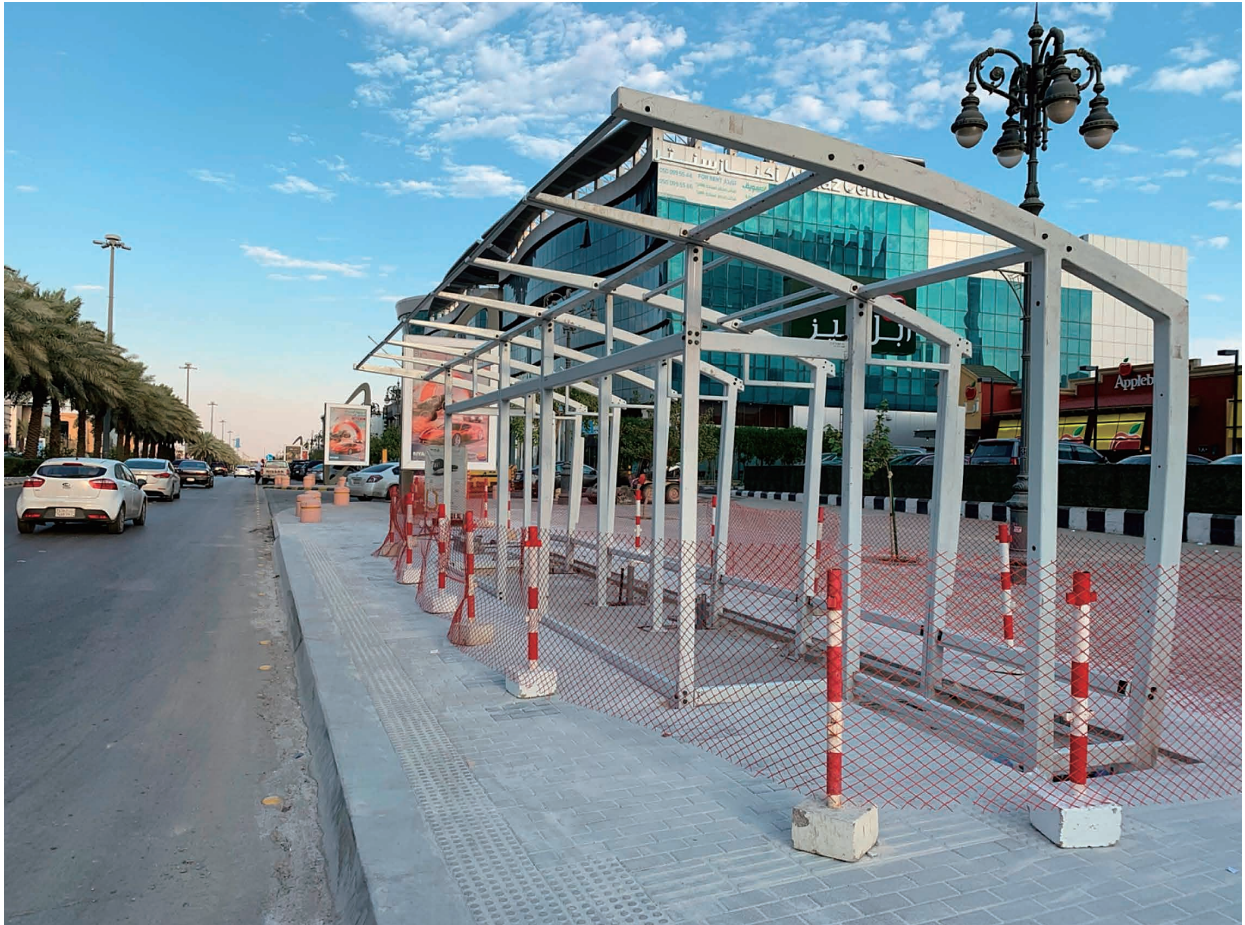
タリア通りに建設中の連結タイプの路線バス停：筆者撮影
